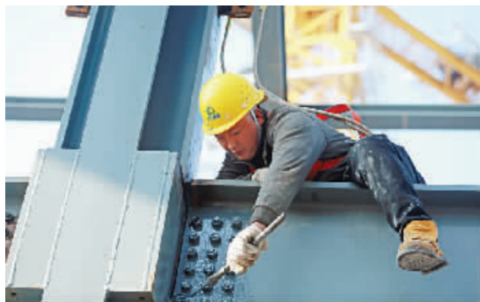
施工人员在给已完工的主体建筑补漆。记者戴越摄
