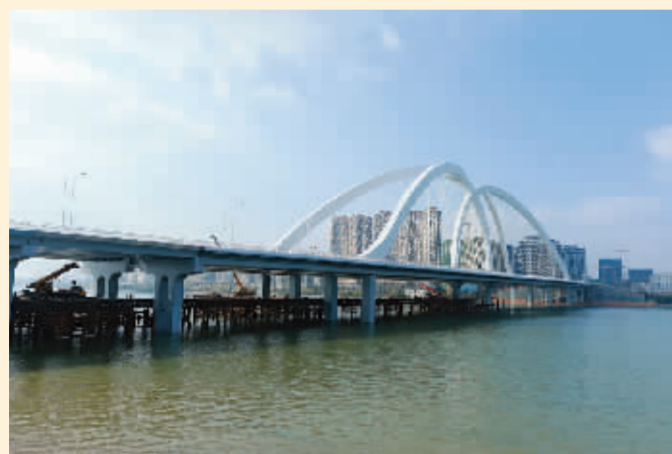
跨越信江两岸的旭日大桥。记者戴越摄
