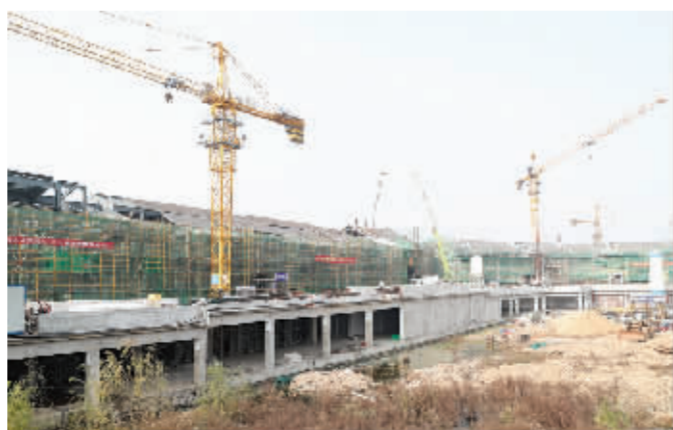
水南街文化街区项目建设现场。记者 夏濂 摄
