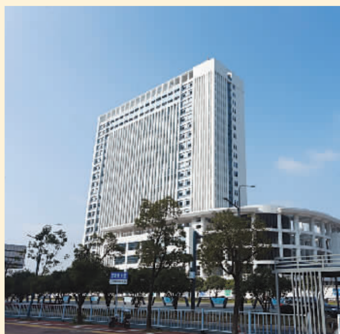
加紧建设的市立医院三江总院。记者戴越摄
