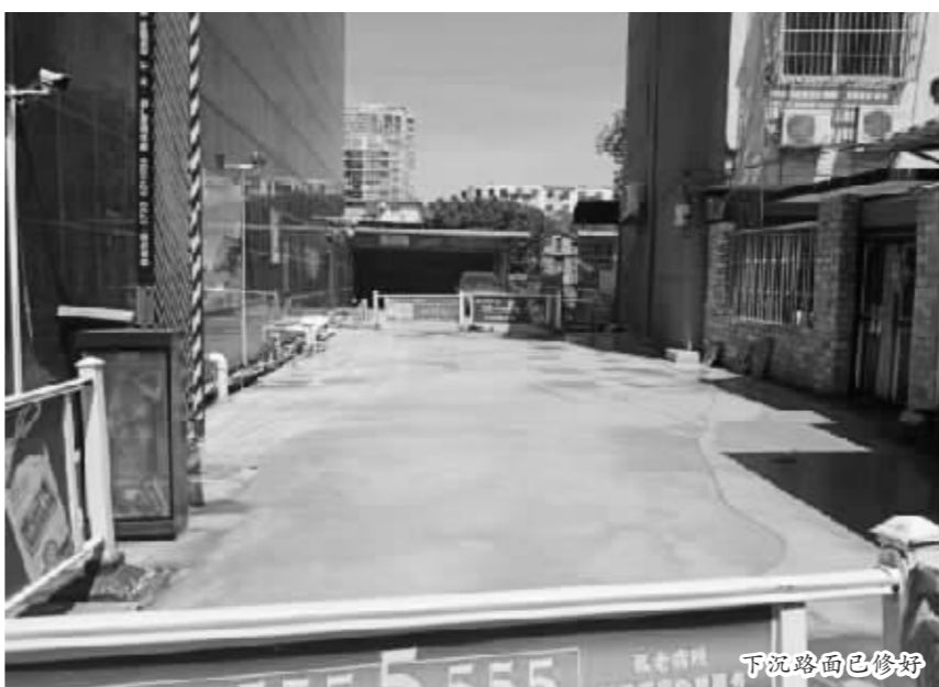
下沉路面已修好
