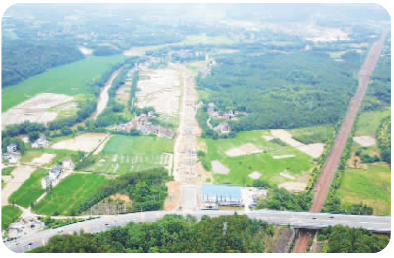
S202玉山绕城项目施工现场
