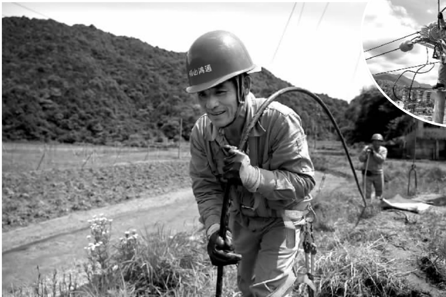
5月25日,国网铅山县供电公司施工人员在天柱山乡开展农村电网升级改造工作。今年以来,该县供电公司加大农村电网升级改造力度,切实提高电网供电可靠性。丁铭华摄
