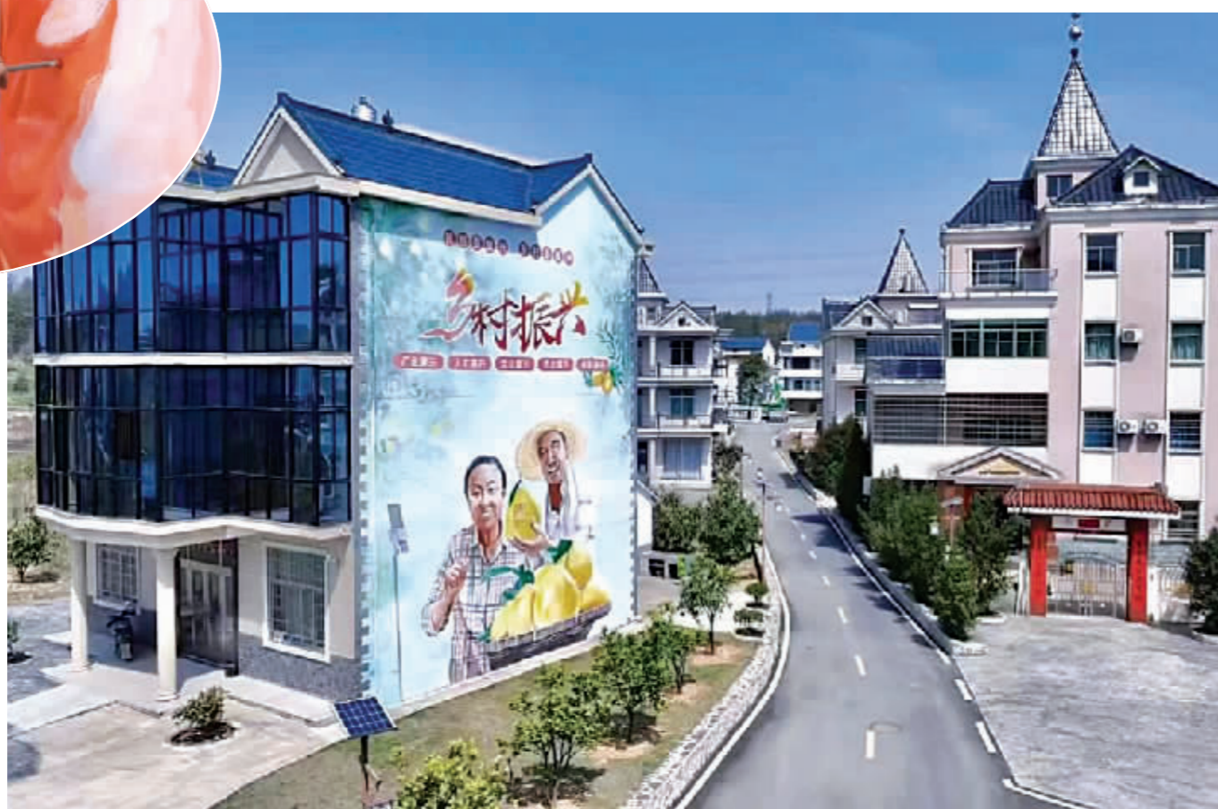
近日,墙绘创作者正在广丰区大南镇马家村新塘自然村的临街墙壁上进行彩绘创作。据了解,该区将整治村庄环境与艺术画相结合,创作出一系列以精神文明建设为主题的多彩墙绘,扮靓美丽乡村。徐嵩沉 夏情 摄影报道
