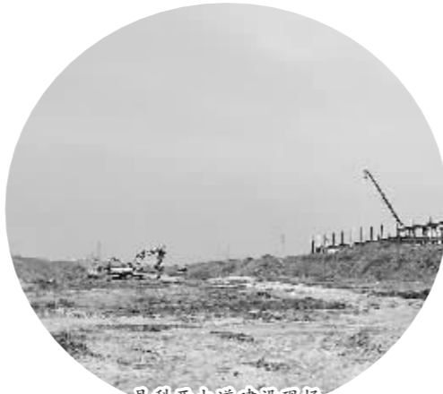
晶科西大道建设现场
