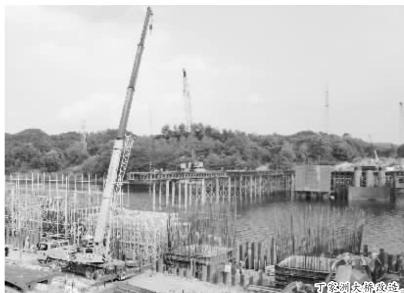
丁家洲大桥改造。
