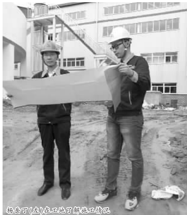
杨岳丁(左)在工地了解施工情况
